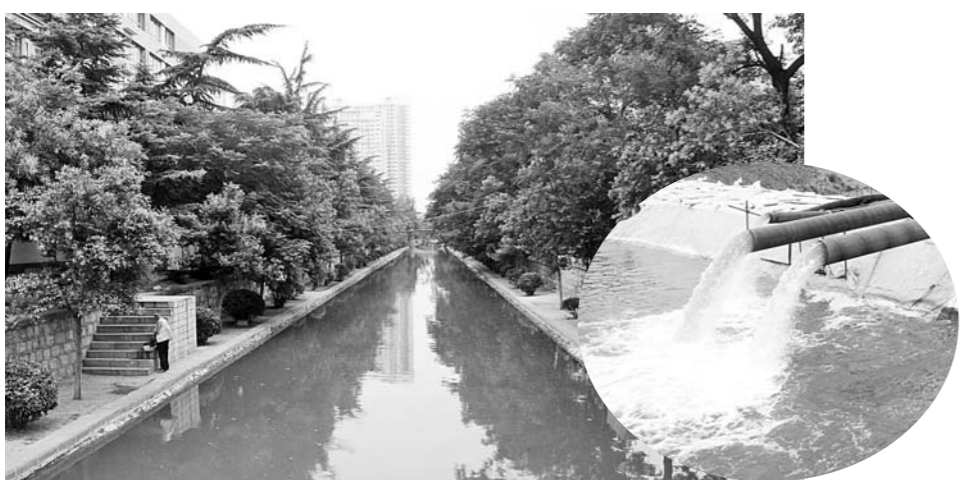
梁济运河泵站提水后，运河水入城。
