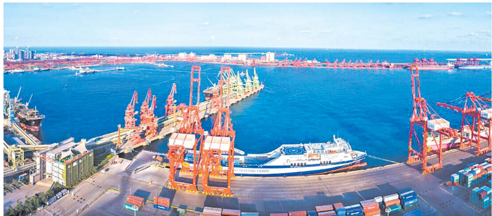
日照港裕廊公司散粮接卸码头一角。
