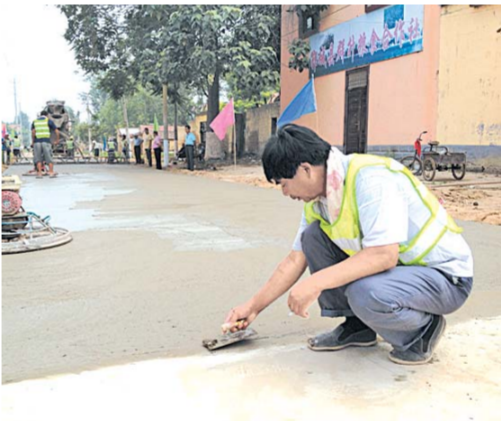
▲ 郓城县随官屯镇三合村道路硬化正在施工。 □ 刘兰英 报道
