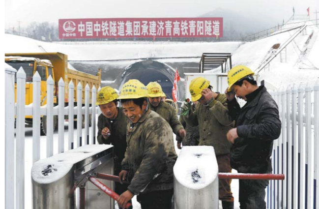
济青高铁邹平段正在积极建设中。
