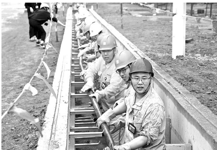
7月7日,大唐临清热电有限公司工作人员正在进行铺设电缆施工工作。
