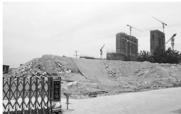
□大众报业记者 周青先 报道 济南一处建筑工地上，工人用防尘网覆盖了裸土。
