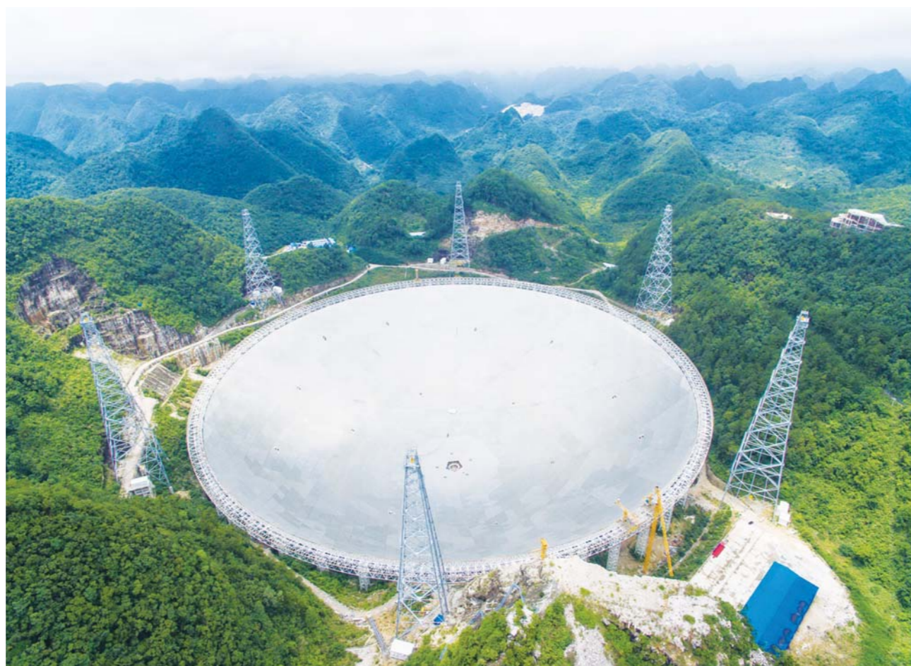
位于贵州黔南州平塘县大窝凼的世界最大单口径射电望远镜FAST主体工程完工。
