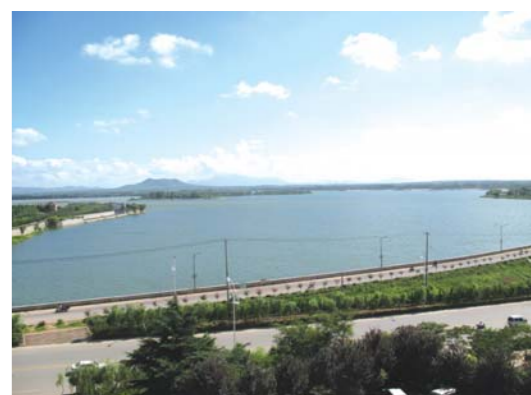
诸城南湖除险加固工程。
