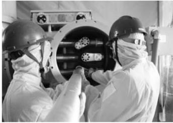
△昌邑市供电公司施工人员在无尘环境下开展110千伏GIS变电设备安装
