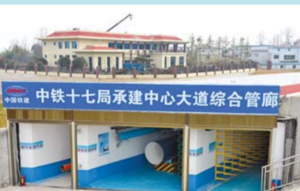
贵安新区中心大道综合管廊工程
