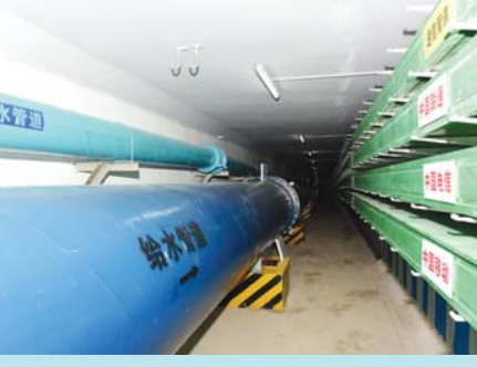
贵安新区综合管廊综合舱内部结构
