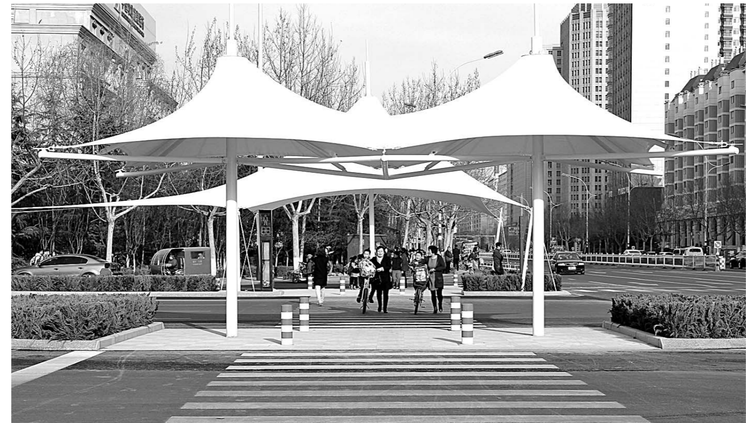
□ 张蓓 高旭菲 王效臣 报道 潍坊高新区最近对8处路口进行改造，其中部分路口增设渠化岛。行人、非机动车车道比车行道稍高一点，自行车可以直接骑上去。行人、非机动车在等红灯时站在上面，会有更安全感。目前，所有工程均已投入使用。图为居民正通过东风东街富华路口新建成的渠化岛。
