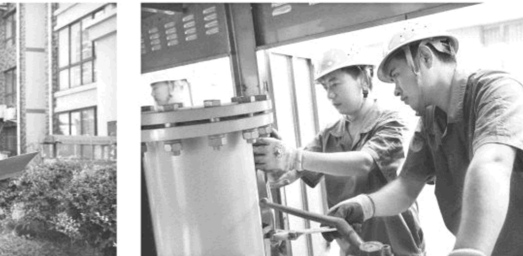
△滕州华润燃气工作人员在进行设备维护
