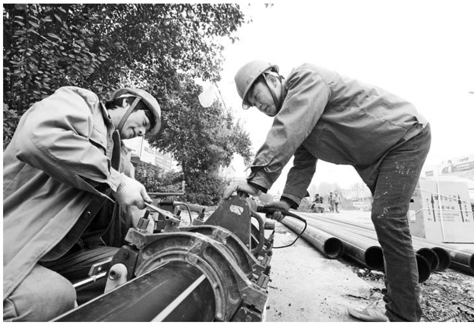
东郭镇镇域天然气施工现场。
