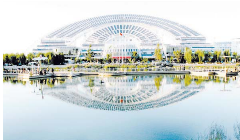
△中国太阳谷—微排大厦
