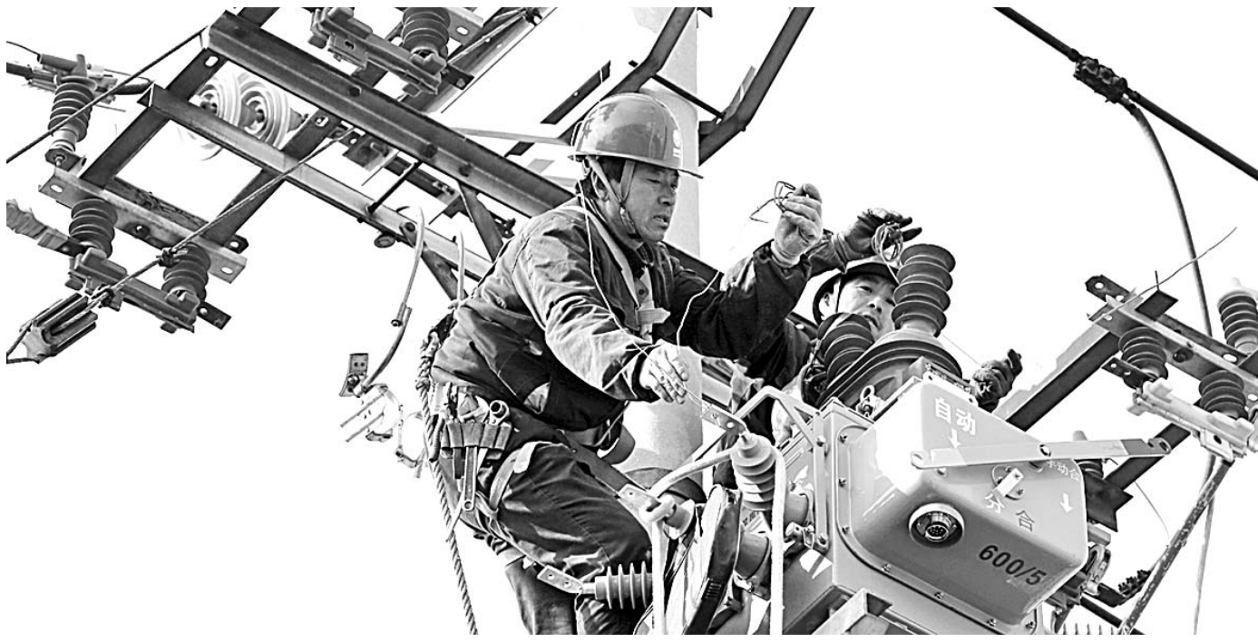
□王宪才 倪广彪 报道 3月27日，国网莱苑市供电公司员工对110千伏城北变电站10千伏北工线实施线路绝缘化治理、双线索改造完善，对#1、#36、#56杆加装支持绝缘子，线下树木修剪、更换避雷器，为电网迎峰度夏做足准备工作。
