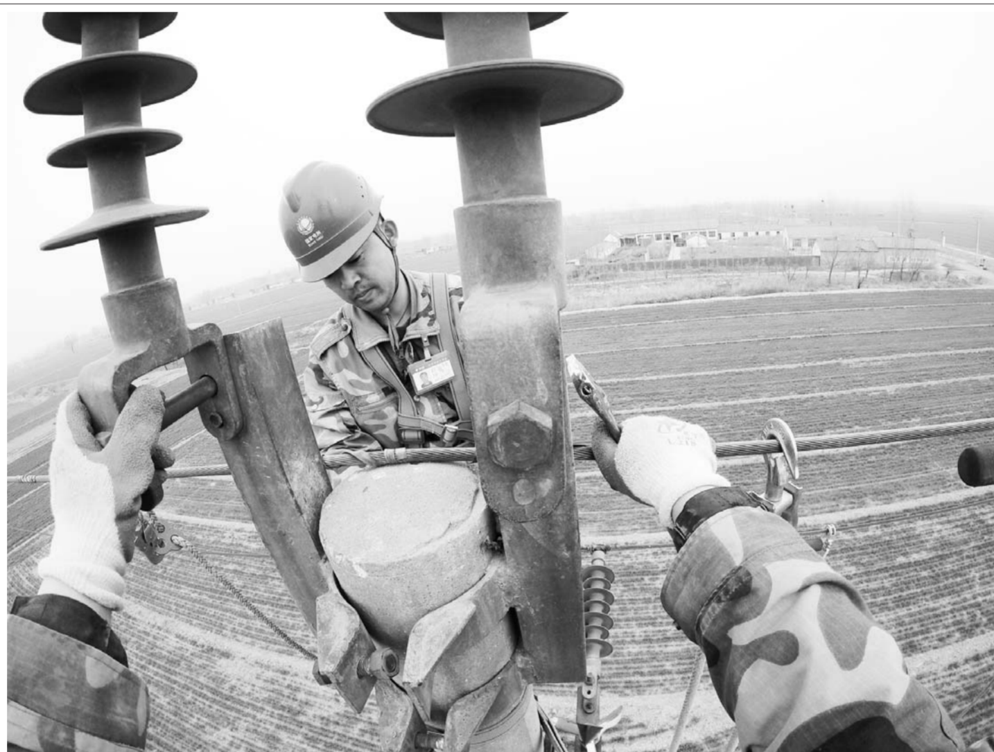
□王雪 张思凯 报道 为保障输电线路安全运行，减少线路故障，3月15日，博兴供电公司开展35千伏吕艺线登杆检修。经过一天的紧张施工，该公司圆满完成了35千伏吕艺线#32、#38、#47、#48、#49等5基杆塔更换横担的春检任务，大大提高了该线路设备健康水平。
