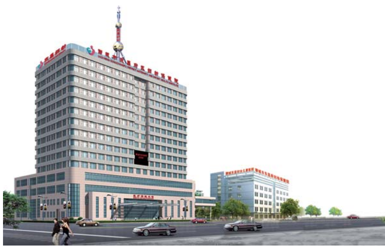
△东昌府区妇女儿童医疗保健大楼
