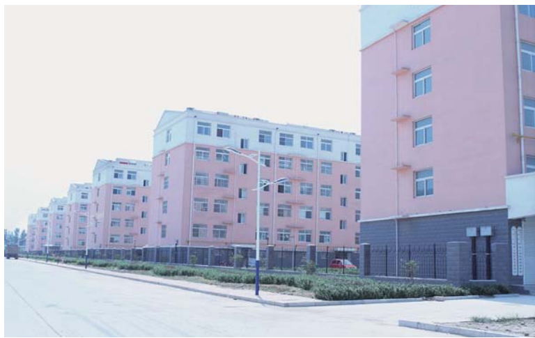
△设施齐全的社区，让居民安居
