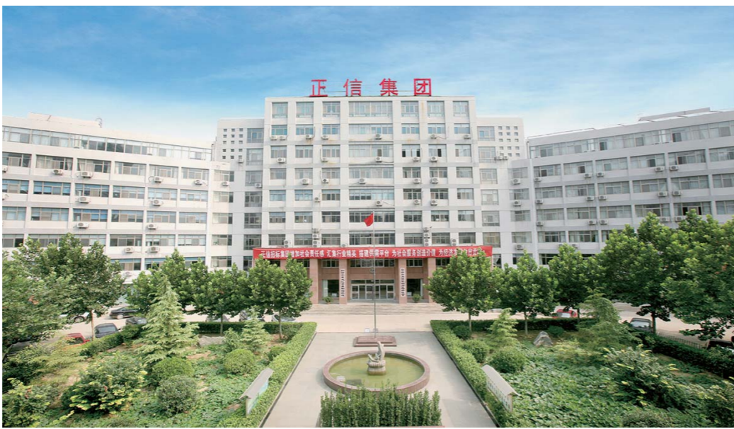
△正信集团办公楼
