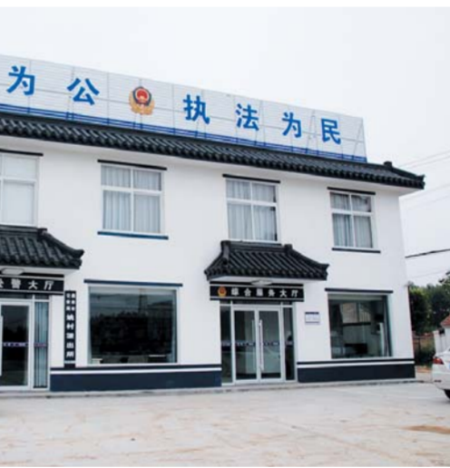
△新建成投入使用的示范化派出所
