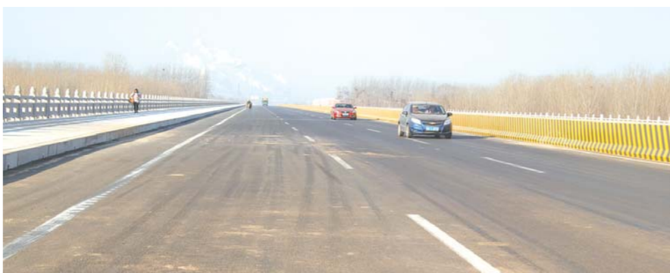
新建成的安顺街弥河大桥成为寿光东西贯通的要道,进一步完善了该市北部的路网体系。
