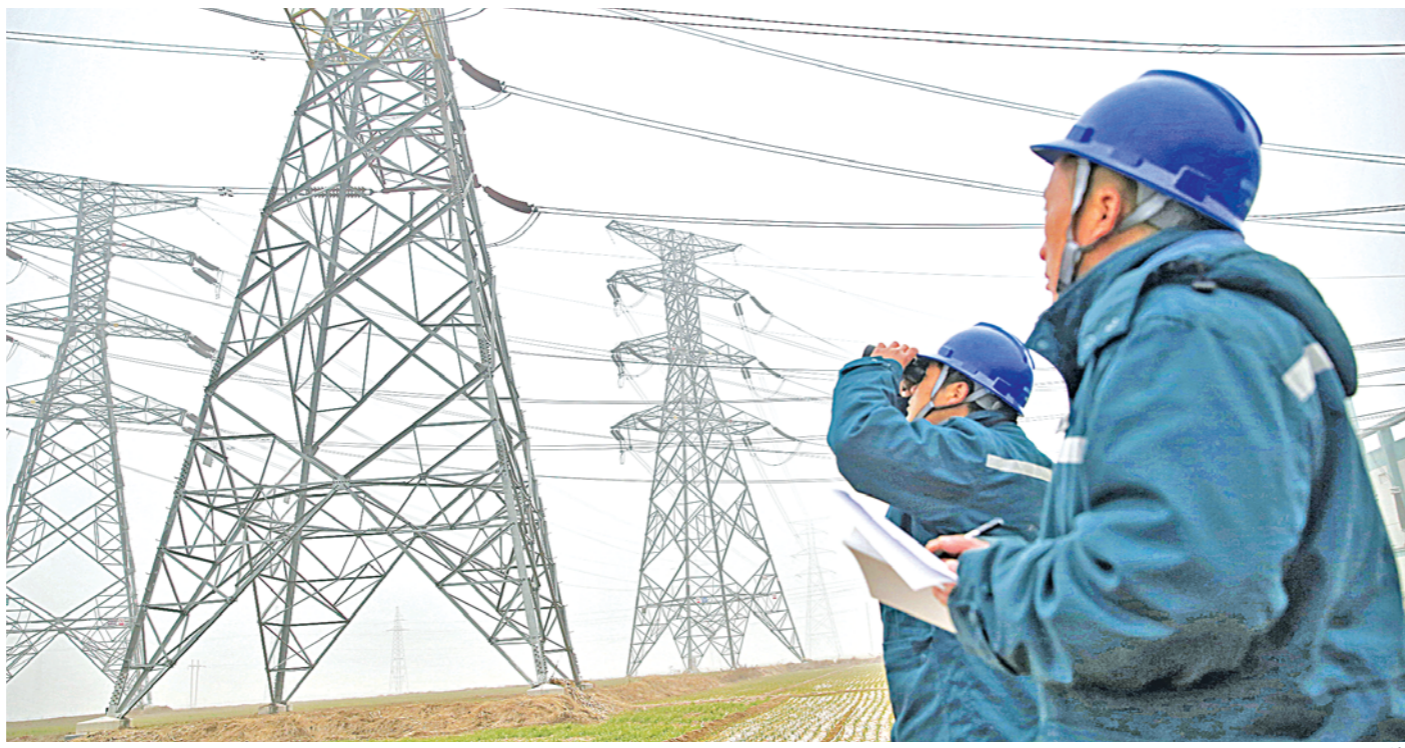
□李庆瑞 报道 成武县连日遭遇雾霾天气,雾霾的湿度会导致设备外绝缘表面受潮,绝缘能力下降,造成供电设备故障短路。为此,国网成武县供电公司启动防止恶劣天气电网应急预案,对供电设施开展地毯式巡视,及时处理设备隐患,保障电网可靠运行。图为1月4日,该公司组织人员对供电设施开展特巡工作。
