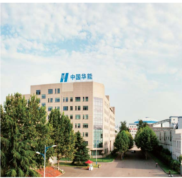
△黄台电厂全景
