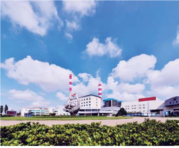
△日照电厂全景
