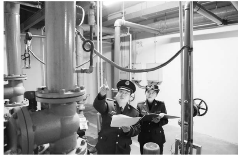
△聊城消防深入企业开展消防安全检查
