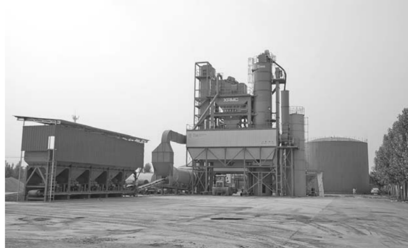
△先进的沥青拌合站
