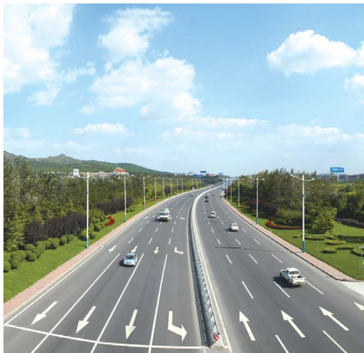
△实施路域综合整治后的国道309济南段
