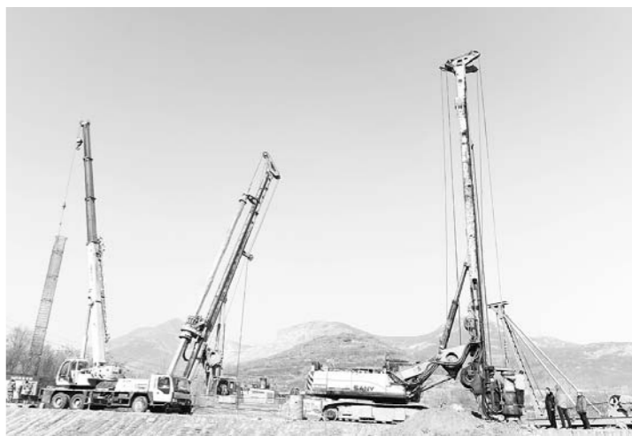
12月28日，工人在济青高铁邹平段施工。济青高铁的建设将进一步促进我省区域经济协调发展。
