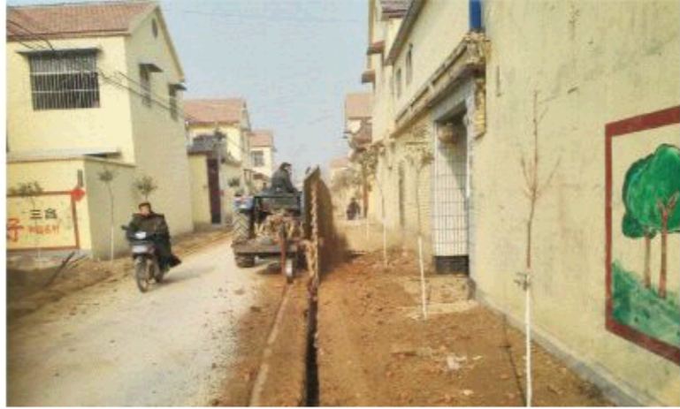
△三合东村村民正在开挖排水管道沟
