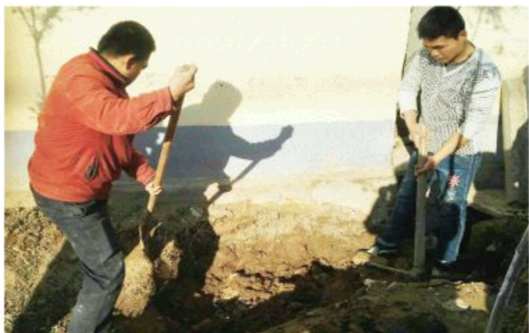
△三合东村村民正在开挖设备安装基槽
