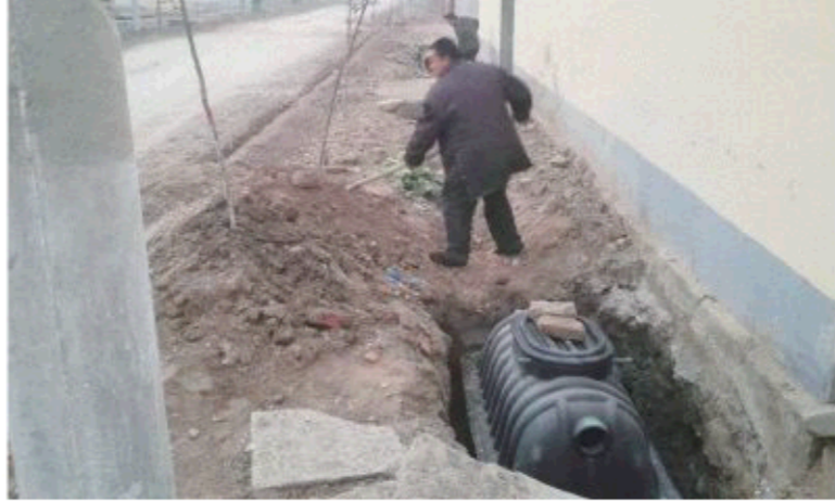
△三合东村村民正在开挖设备安装管道沟
