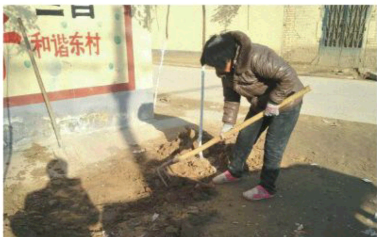
△三合东村村民在开挖基槽
