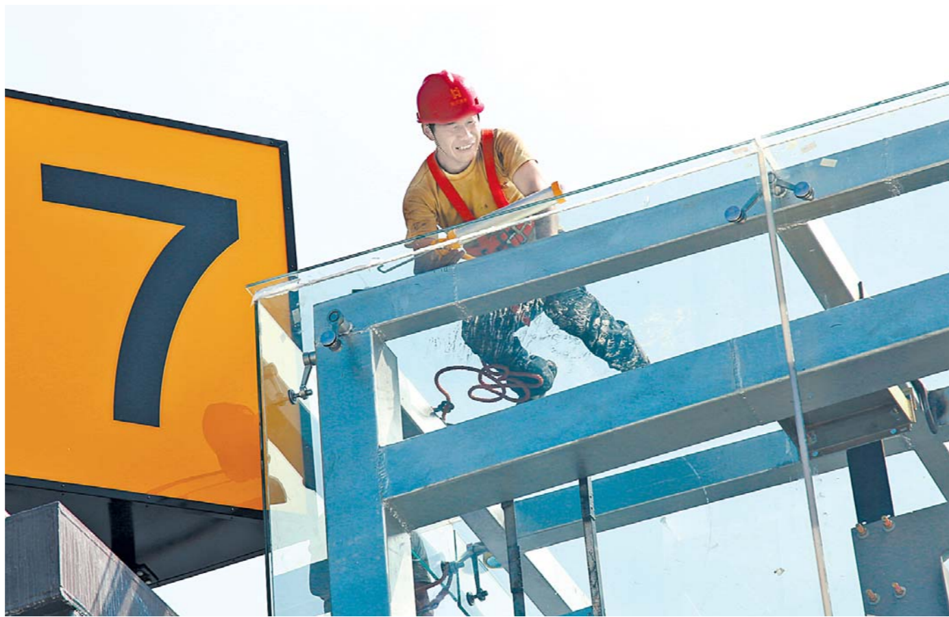
▲日照机场667天完工的背后，是建设者们加班加点的艰苦奋斗。（资料片）
