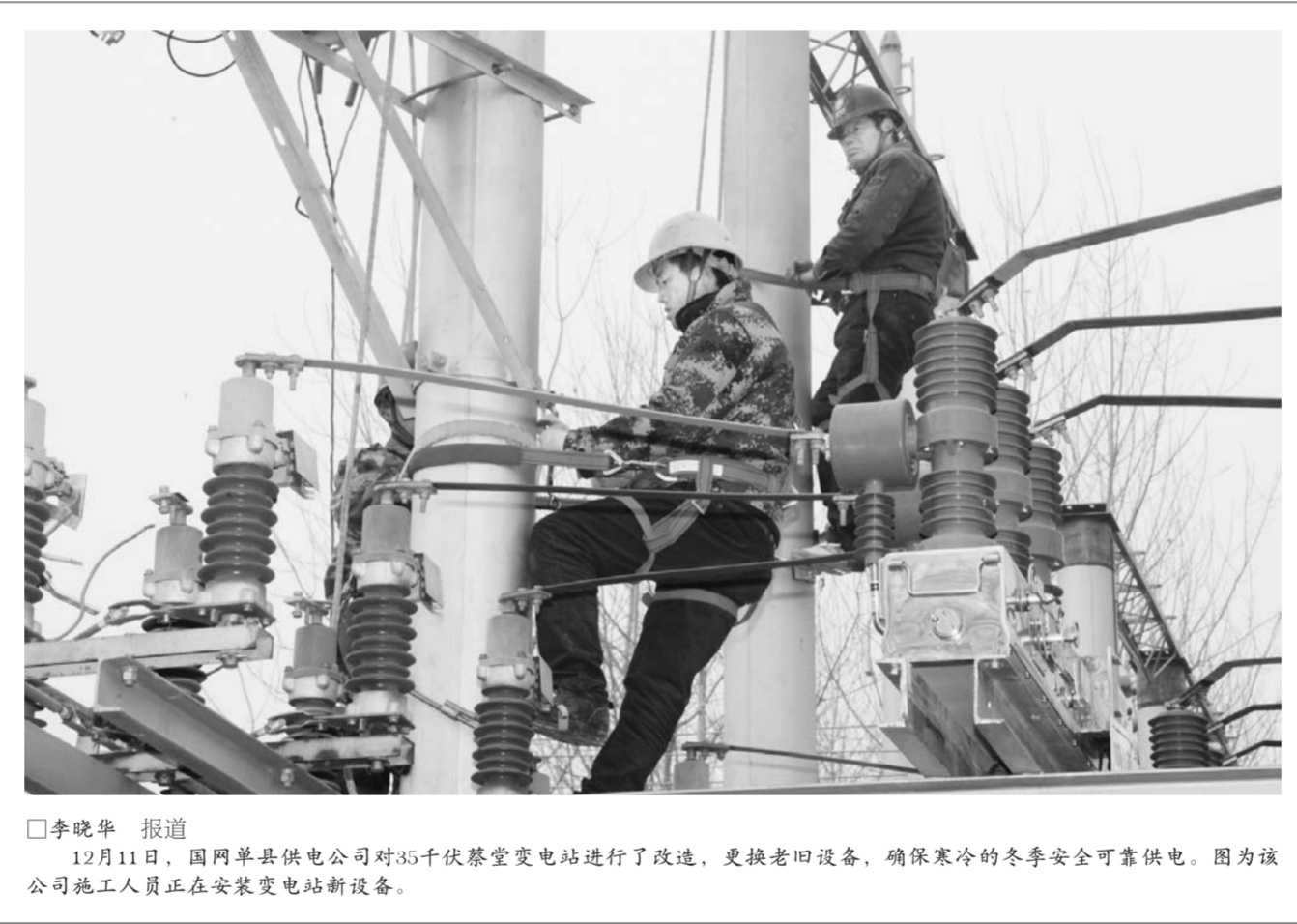
□李晓华 报道 12月11日，国网单县供电公司35千伏蔡堂变电站进行了改造，更换老旧设备，确保寒冷的冬季安全可靠供电。因为该公司施工工人正在安装变电站新设备。
