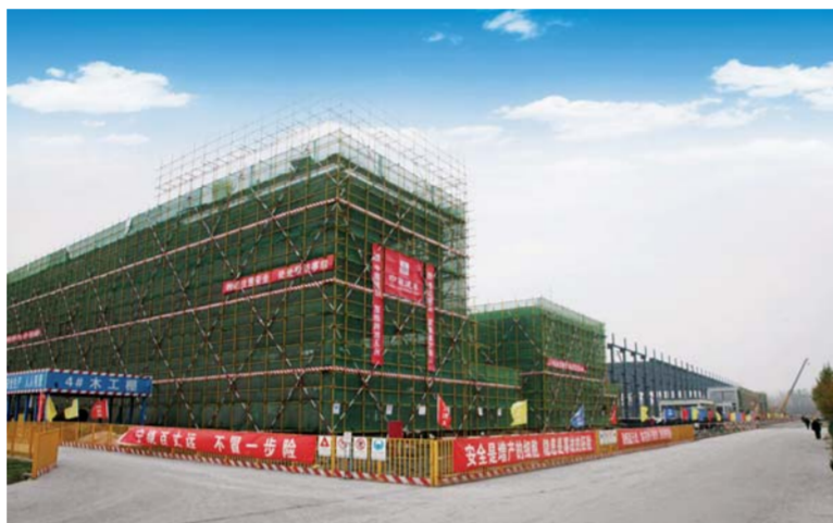
△建设中的北汽滨州生产基地
