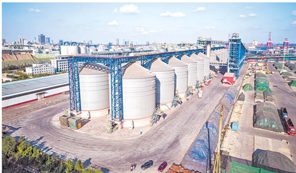
▲从散粮的到港、卸船到入仓、装车，日照港裕廊公司凭借5.5公里的传送带和智能系统，实现了散粮的精准输送。图为港裕廊公司散粮三期工程新建筒仓。(资料片)
