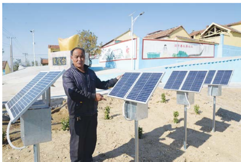
△莱芜市南宝台村,太阳能微动力污水处理系统正在运行。处理后的污水可以用于农田灌溉。
