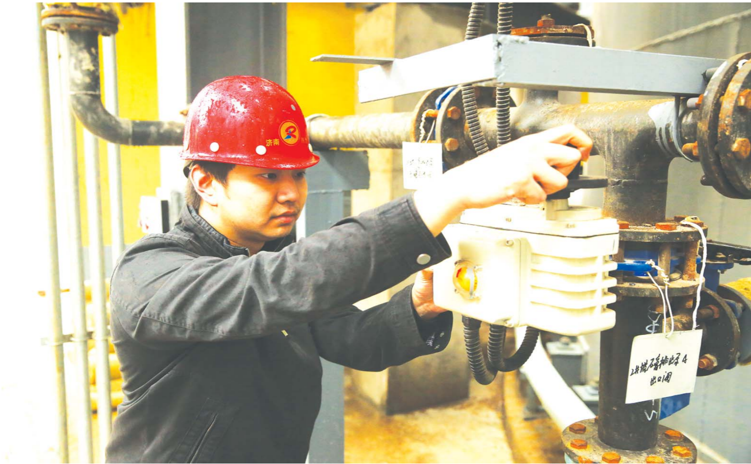
济南热电推进节能环保项目建设,新建脱硫设备。
