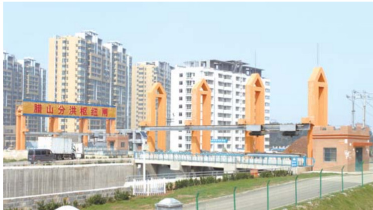
△腊山分洪工程枢纽闸
