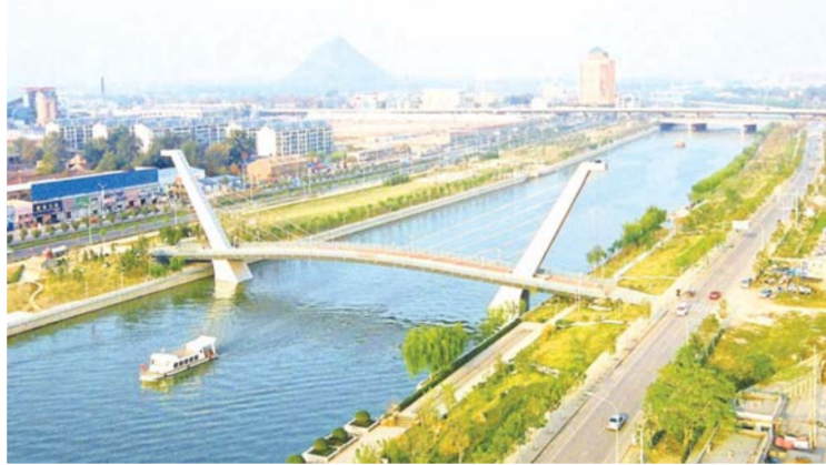
△小清河综合治理工程
