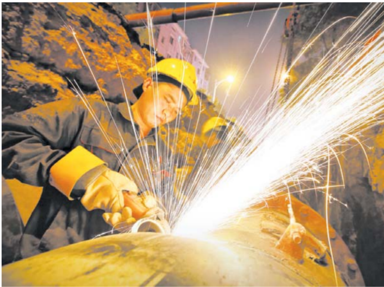
△工人们正在进行管道施工
