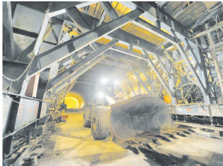
△二环南路老虎洞山隧道施工
