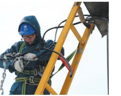
□王宪才 报道 11月24日,国网莱芜供电公司变电检修室员工在220千伏长勺变电站冒雪更换电流互感器,并对二次回路进行完善。一场旷日持久的雨雪让莱芜的最低气温降至-9℃。供电员工克服大风、雨雪和低温带来的困难,一丝不苟地对电网进行检修。
