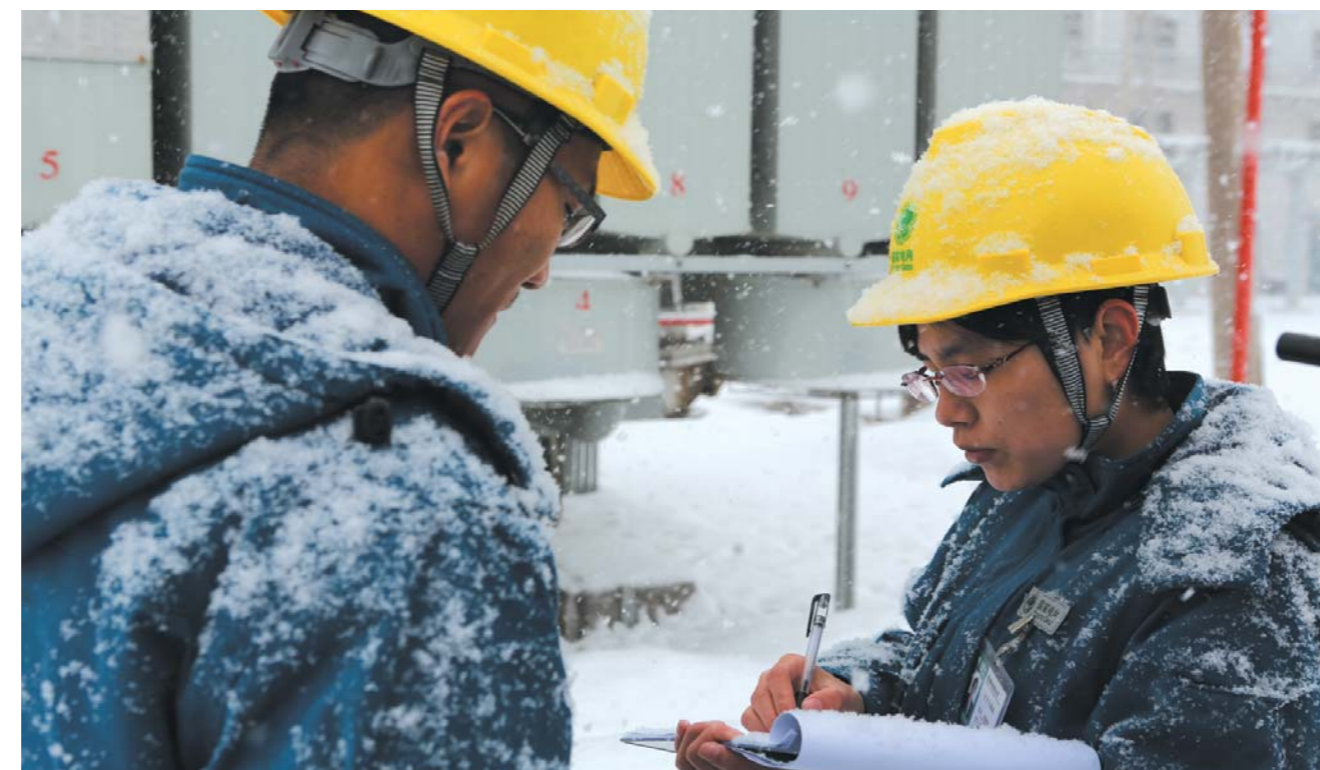
□赵蒙 报道 11月25日,聊城境内普降中雪,部分县市达到大雪级别。气温跌至零度以下,雨雪给供电线路、设备带来了安全隐患。为全面掌握辖区线路设备的运行状况,聊城供电公司组织工作人员对变电站、配电线路和配电台区加强巡视,对重点线路和设备做好特巡工作,确保在特殊恶劣天气下电网安全稳定运行。
