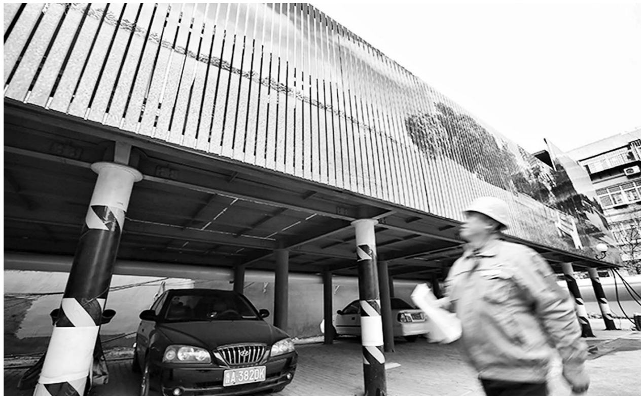
济南市方正园小区运用空气源热泵技术供热，获得用户认可。
