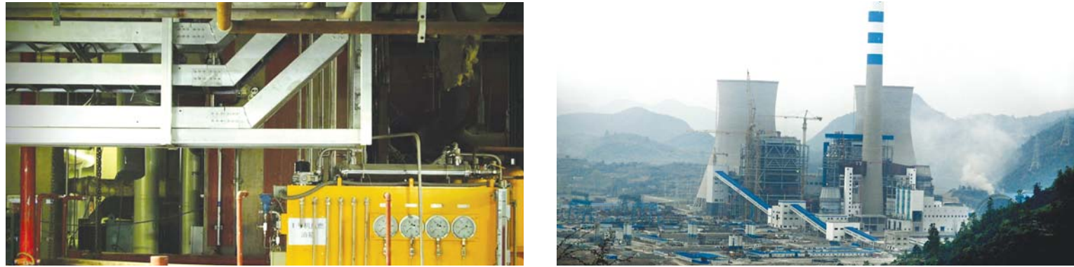
上图:技术人员在调整仪表管路细节。在山东电建二公司被称为“工艺管道”的小口径管道要靠手工安装,形式美同内在质量一样得到重视;下左图:电缆桥架和机燃燃油箱,富有韵律感的色彩和线条;下右图:即将竣工的国电织金发电厂。
