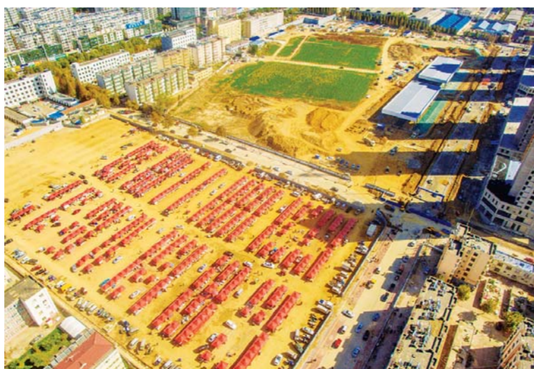
△左为沙墩临时市场，右为正在建设中的沙墩市场
