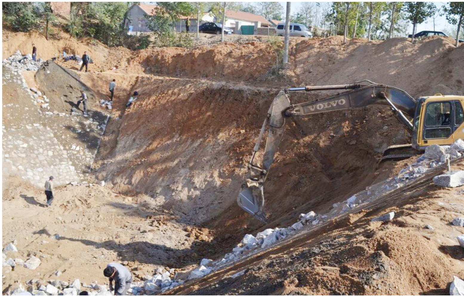
10月30日,昌乐县红河镇大湖田村小农水项目施工现场,施工人员正在给新开挖的方塘铺设石壁。
