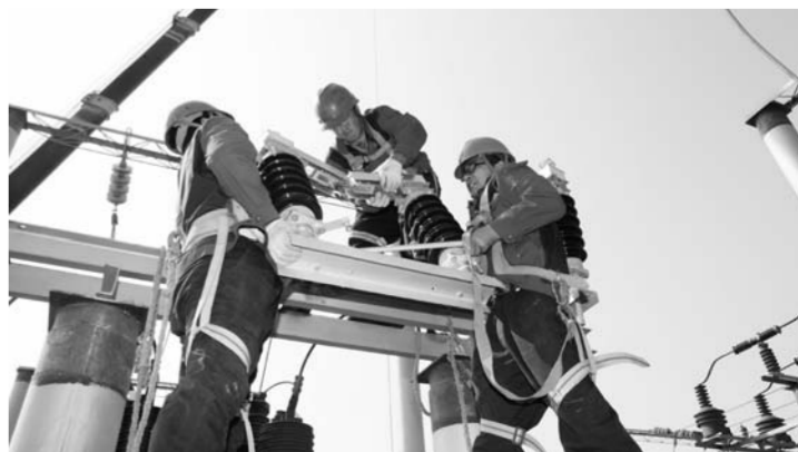
□李晓华 报道 10月20日，国网单县供电公司利用秋检停电时间对35千伏浮岗变电站进行设备改造，提升变电站自动化水平，确保迎峰度冬安全可靠供电。
