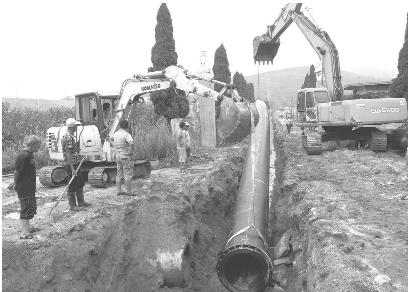
□王成刚 柳新厚 报道 龙口市自7月1日起实施了王屋水库城市应急供水管道改造工程。工程建成后，可增加300多万立方米的供水量，日供水可达6万多立方米。图为施工人员正在安装管道。
