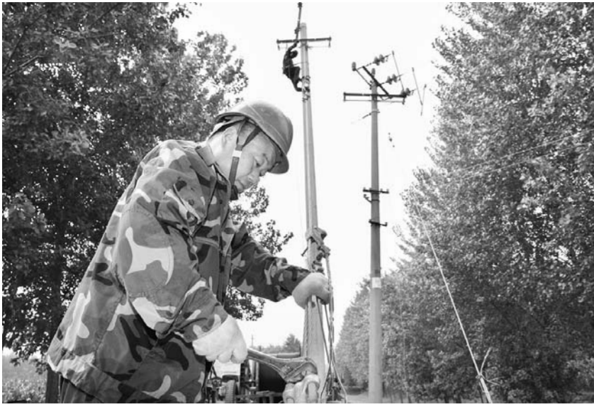
□李晓华 报道 8月4日，在单县黄岗镇贾水口村，国网单县供电公司工程二处施工队正在37摄氏度高温加快推进农网改造升级工程。
