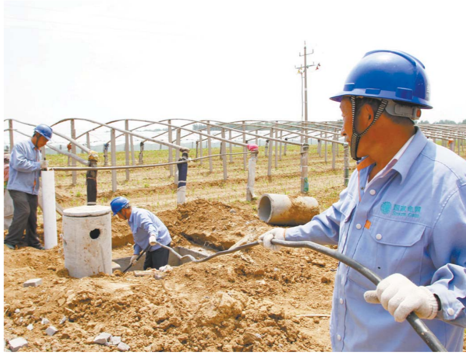
6月24日，昌乐县供电公司工作人员正在为红河镇朱家埠村新钻机井埋设低压电缆。
