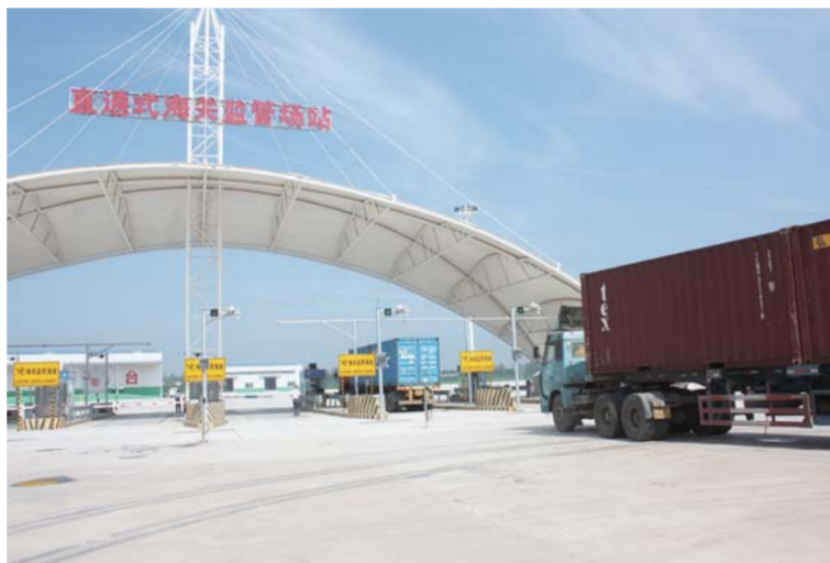
△陆路码头海关直通站
