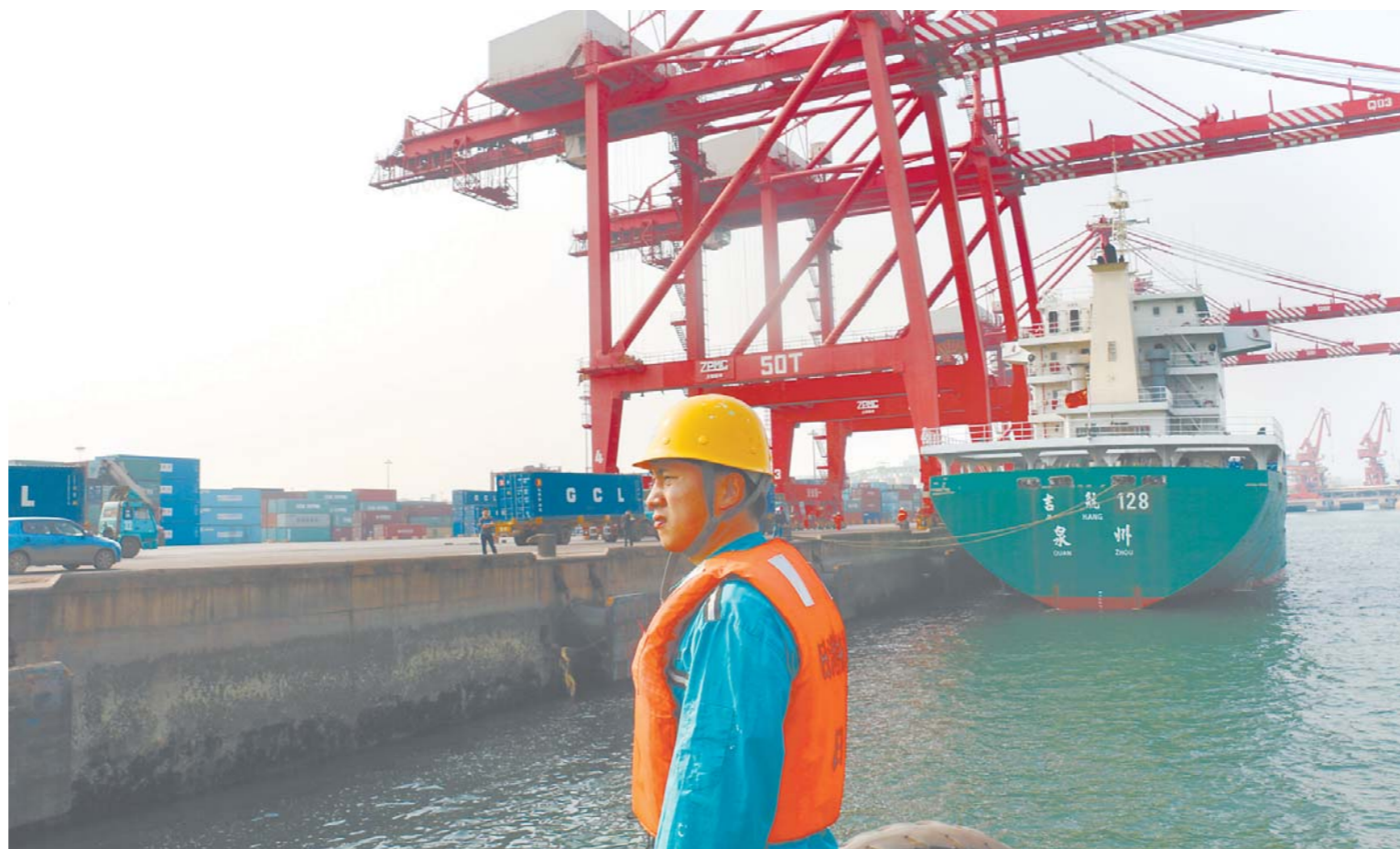
▲5月22日，工人在集装箱码头指挥作业。2014年，日照港完成货物吞吐量3.53亿吨，成为全球重要的能源和原材料运输口岸、煤炭装船港。
