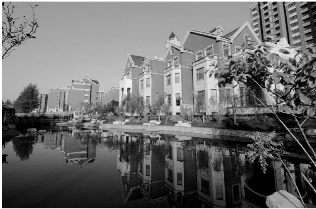
▲淄川区康桥名郡小区的楼房全部按照绿色建筑指标建设。
