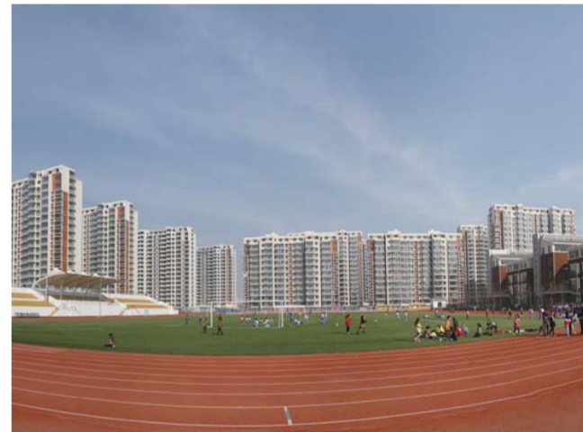
△日照钢铁精品基地安置区
