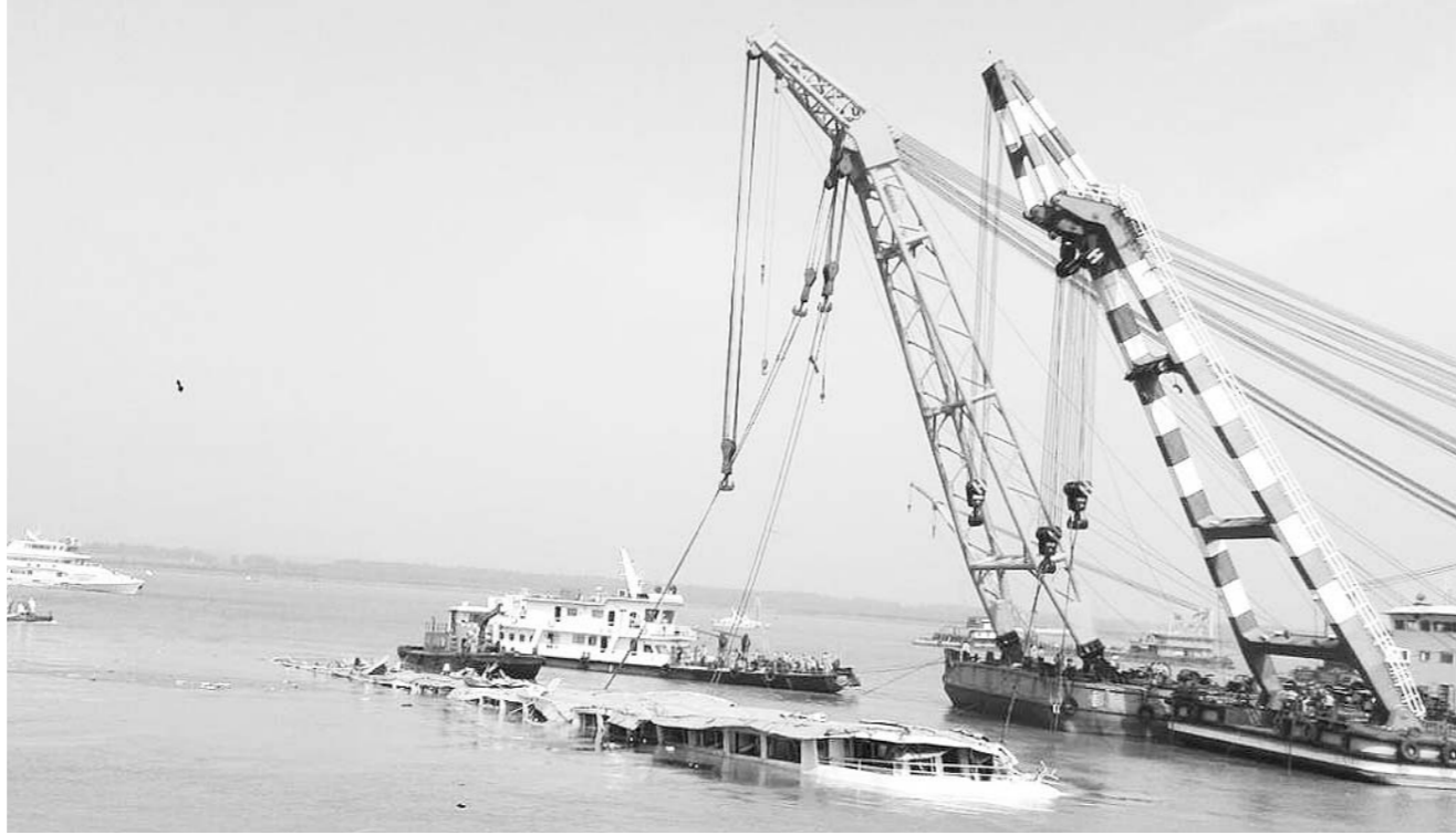
6月5日，两台起吊机器同时作业，将“东方之星”缓慢吊出水面。
